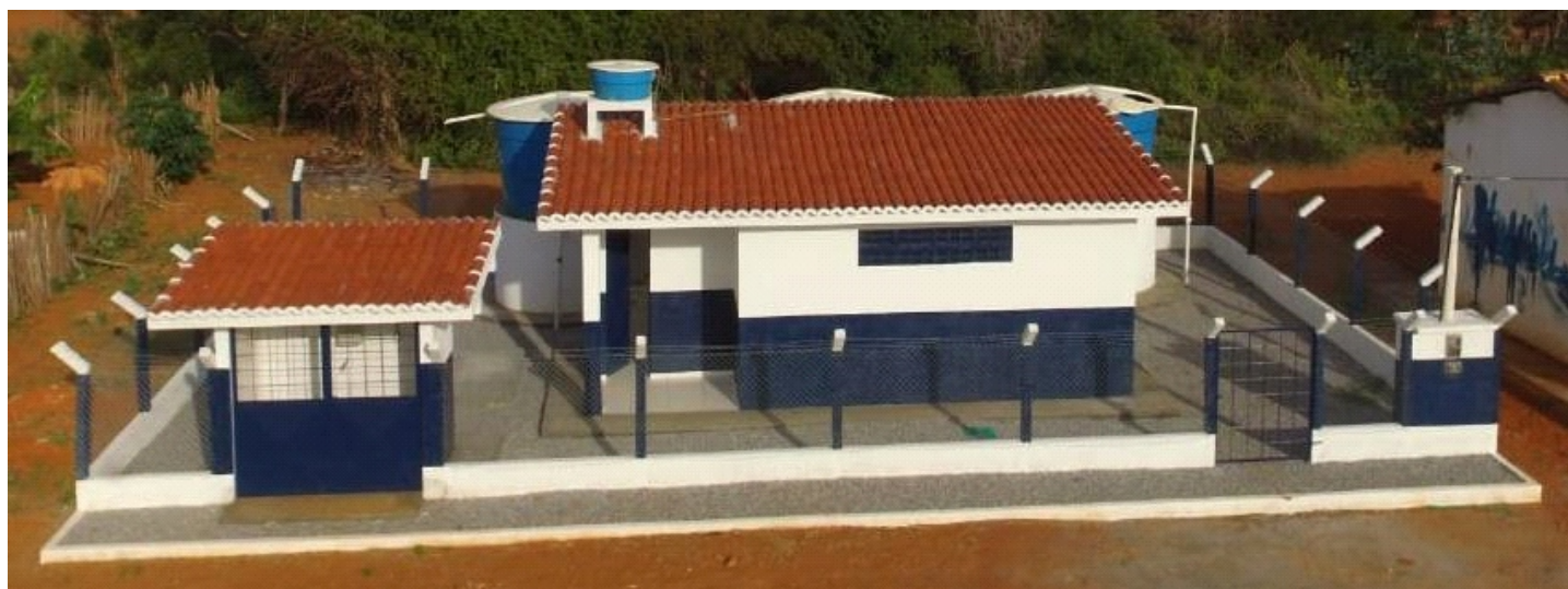
O sistema de dessalinização - Comunidade de Fazenda Nova - Município de Campo Formoso (OUT/2020)
