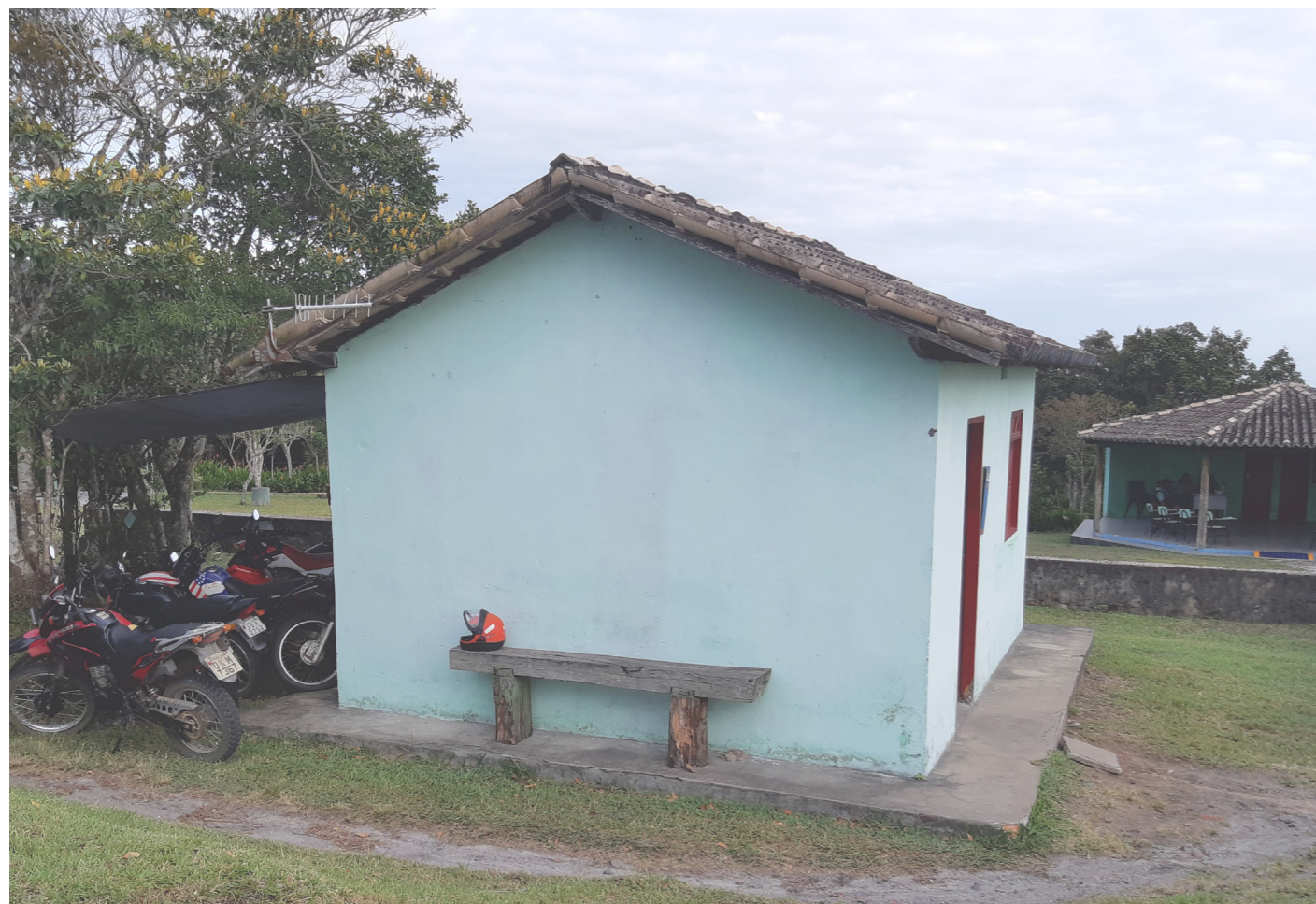
Figura 10. Foto da edificação. Fonte: visita técnica feita pela equipe em fevereiro de 2021
