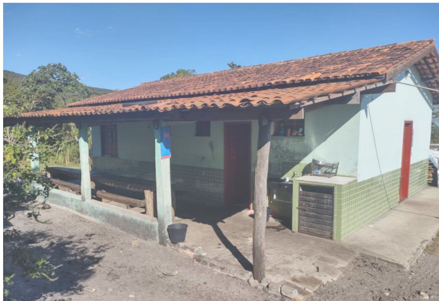
Figura 16. Foto da edificação. Fonte: visita técnica feita pela equipe em fevereiro de 2021
