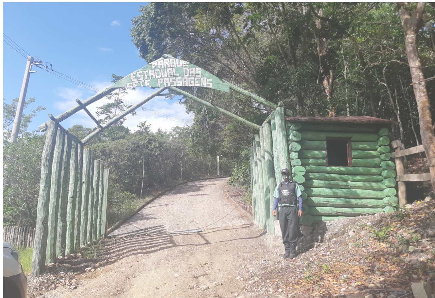
Figura 8. Foto da edificação. Fonte: visita técnica feita pela equipe em fevereiro de 2021
